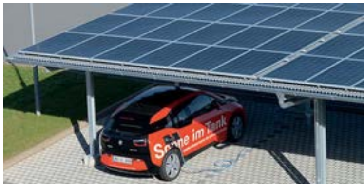
Figura 32 esempio di pensiline fotovoltaiche per ricarica automezzi
